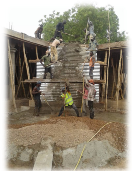
Neubau Internat Kandi, beim Dachbau mit Etagen, mit denen sie Beton hinaufbefördern
