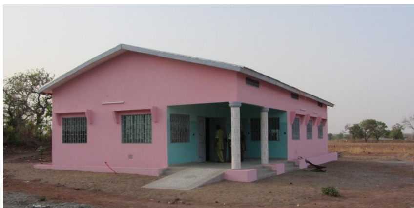
Das Hauptgebäude des neuen Dispensaires in Gamagou steht!
